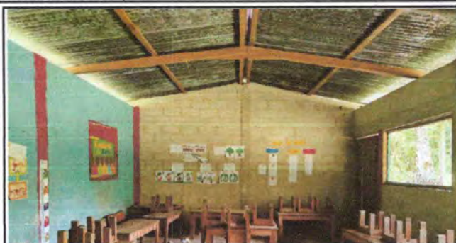
Foto 1: Desmontaje de madera por estructura de metal y cubierta de lamina. Así mismo se aplicara pintura en el interior del establecimiento.
