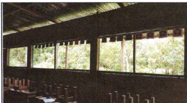
Foto 4: Sustitución de ventanas de madera y malla, por balcones de metal.
